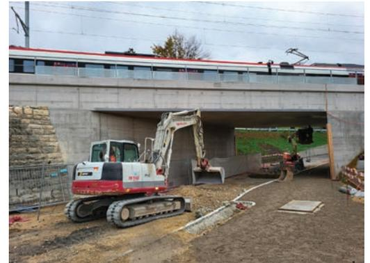
12.11.2024: Le nouveau pont réalisé en 2024, renforcé et élargi. Des parois antibruit viennent nouvellement compléter l'ouvrage au nord des voies.
