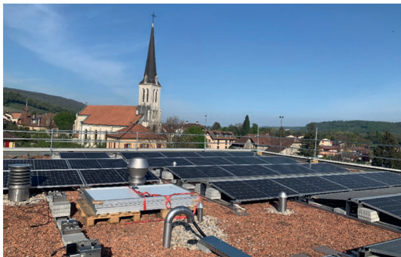
Vue de la toiture pendant l'installation
