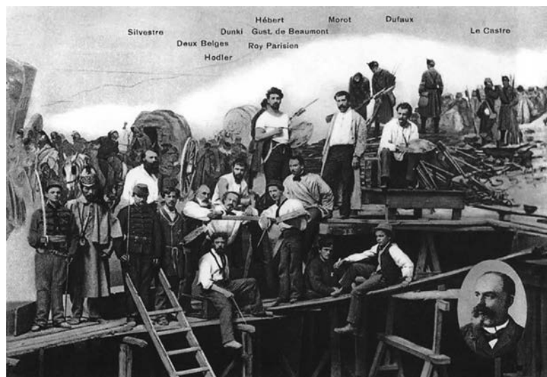
Le chantier de la création du Panorama avec les peintres acteurs et des figurants.
